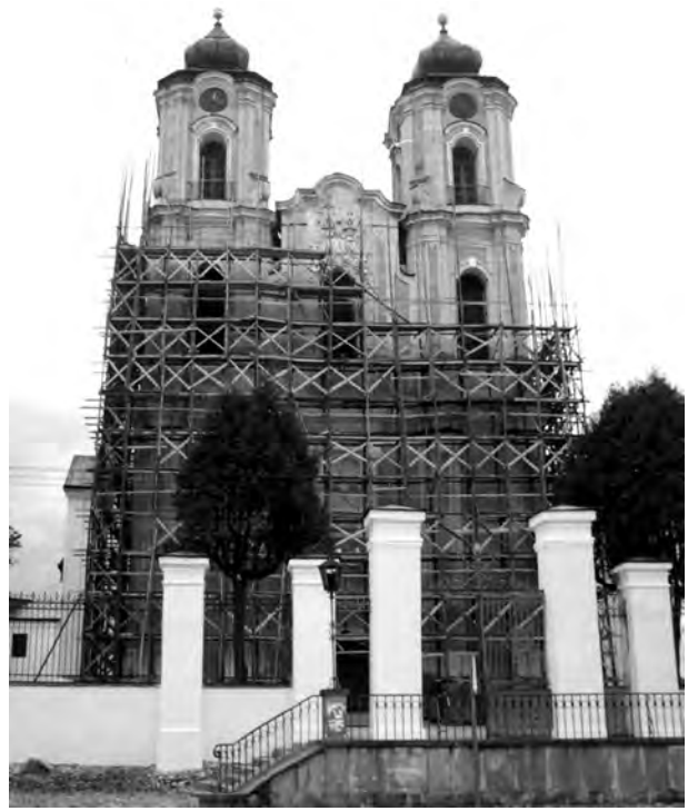
3. Fasada bazyliki w Sejnach. Stan w trakcie prac remontowych z 1997 r. Fot. A. J. Koseski
