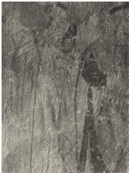
Ryc. 52. Fragment wadliwie odsłanianej polichromii. Widoczne ślady nacięć ostrym narzędziem. Ściana południowa fragment lewej strony kompozycji.
