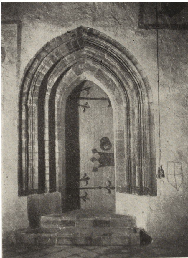
Ryc. 55. Portal na ścianie północnej. Wejście do zakrystii.
