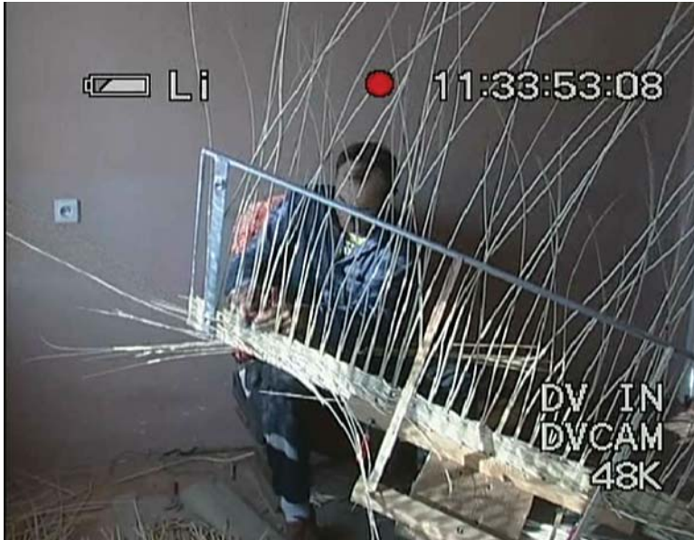
Il. 8. Pawilon Polski EXPO 2005. Elewacja wiklinowa. Proces wyplatania elewacji (archiwum K.I.)
