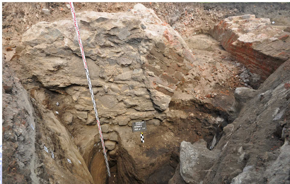
Ryc. 12. Unisław - fundament arkadowy północnej ściany domu zamkowego (fot. B. Wasik).
