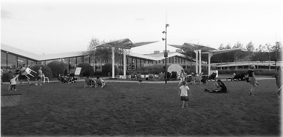
Fot. 1. Dach Galerii Północnej w Warszawie
