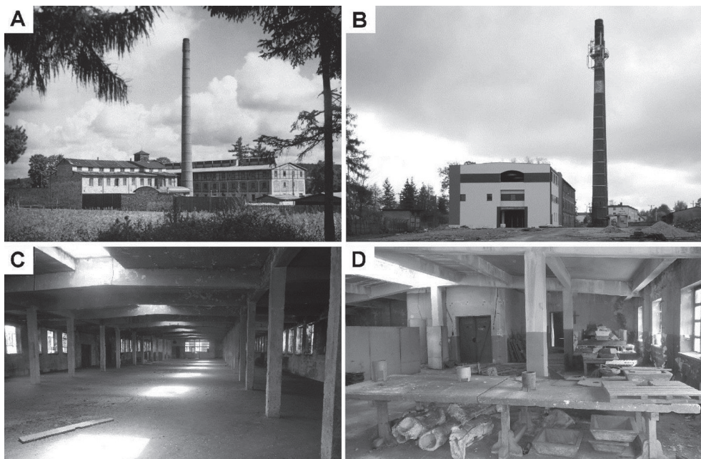
Fot. 2. A) Marywil na początku XX w. 30 , B) obiekt w 2018 r. (fot. P. Przepióra), C) i D) wnętrze hali produkcyjnej przed rozbiórką w 2015 r. (fot. archiwum S. Piasta 31 )
