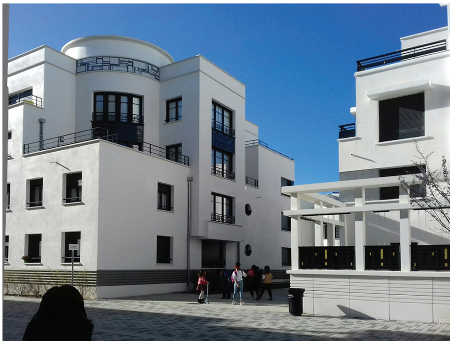
Dessin 18. Zac des Studios, Bâtiment semi-collectif, inspiration M. Stevens, Art Déco Source: archive d'auteur
