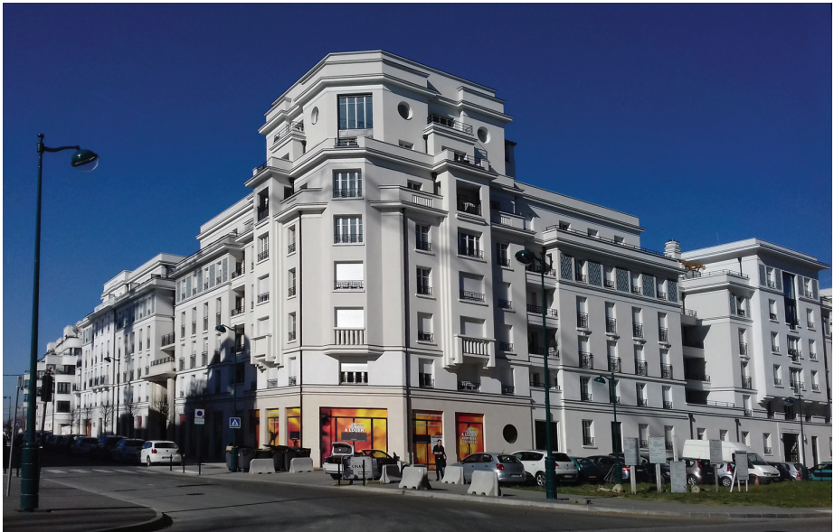
Dessin 16. Zac des Studios, Bâtiment d'habitation en cours de réalisation Inspiration Art Déco, Architect M. Culot
