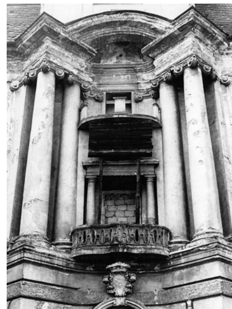
il.24 Pieszyce, pałac, fasada, ryzalit środkowy z balkonem nad wejściem głównym, stan przed remontem. Fot. R. Hołownia
