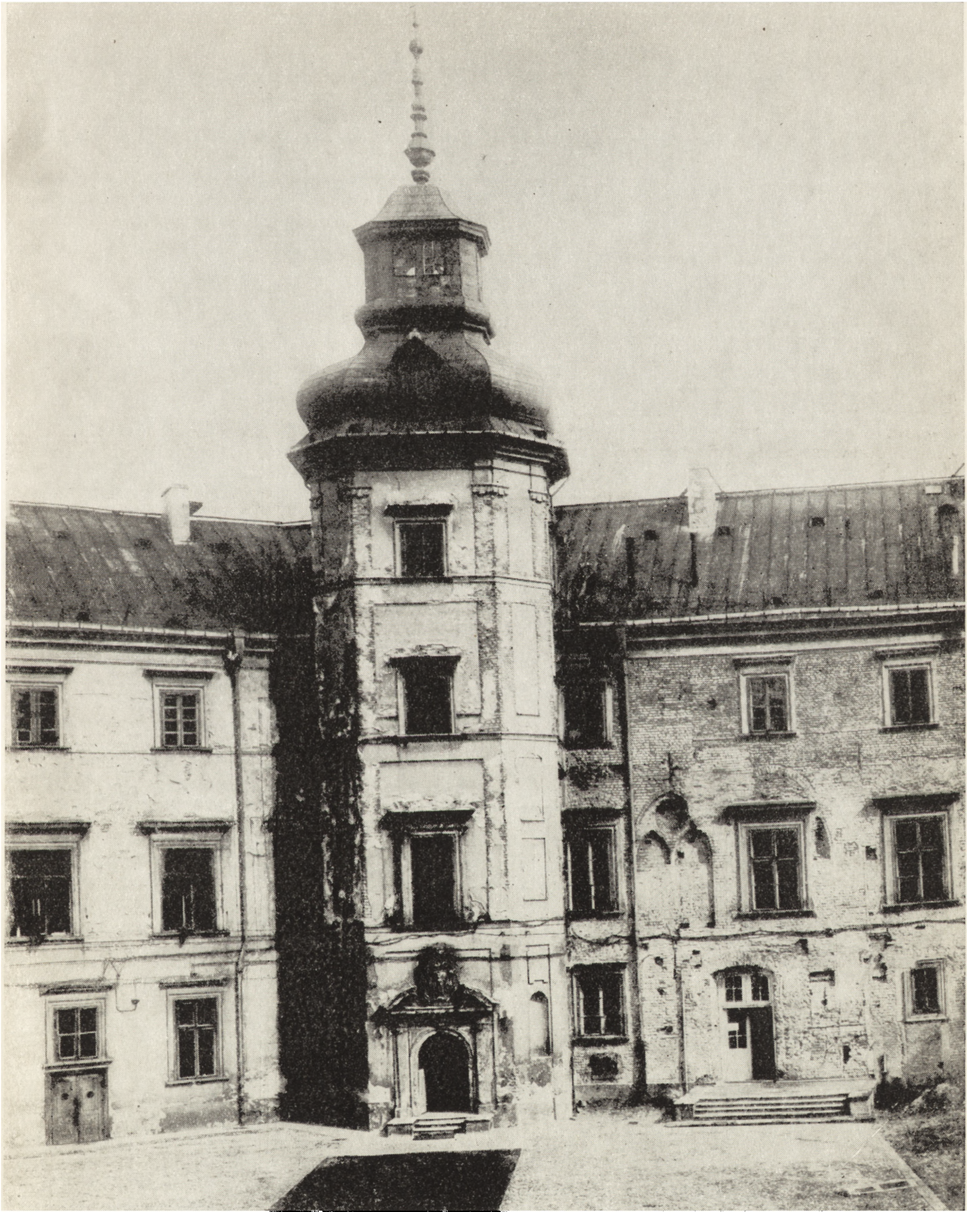
2. Zamek Królewski w Warszawie, Wieża Władysławowska, zdjęcie z r. 1924 (neg. arch. I. S. 10083), które posłużyło do fotogrametrycznej rekonstrukcji obiektu
