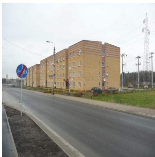
Ryc. 11. Białystok – budynek przy ul. Św. Eliasza (Fot. A. Tokajuk)
