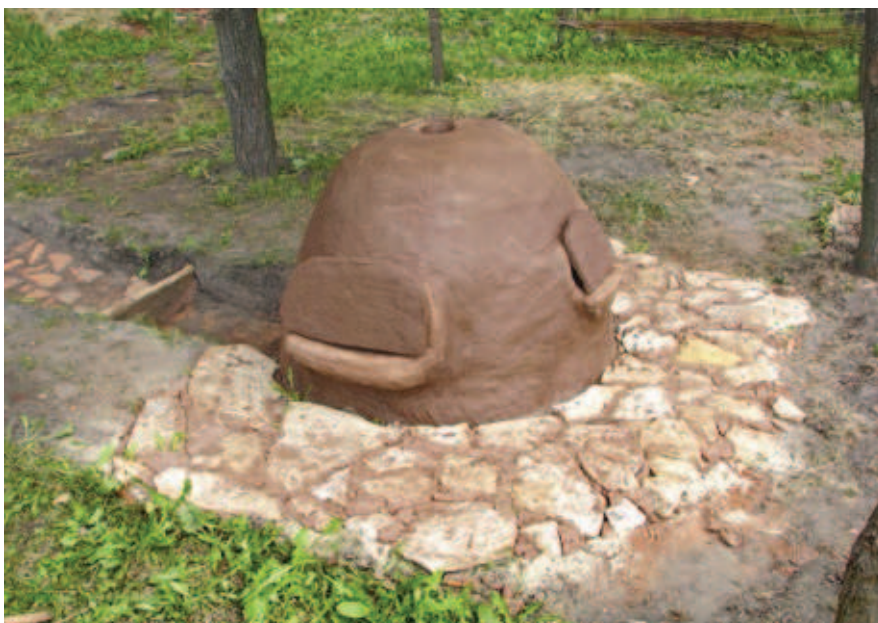
Ryc. 6. Piec podczas schnięcia; fot. M. Krzyżanowska Fig. 6. Drying of the furnace; photog. M. Krzyżanowska
