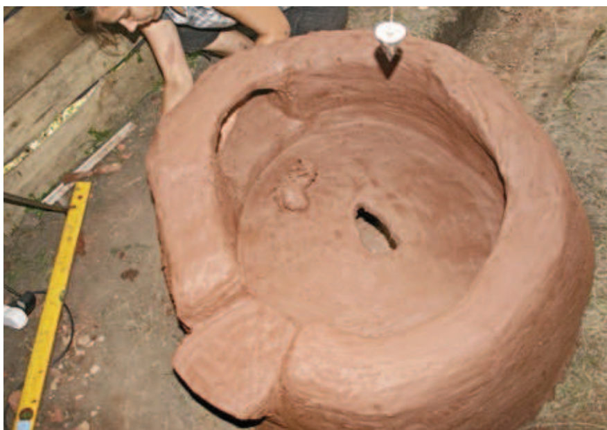
Ryc. 4. Budowa ścian komory górnej oraz znajdujących się w niej otworów; fot. M. Frankiewicz Fig. 4. Construction of the upper chamber walls and its openings; photog. M. Frankiewicz
