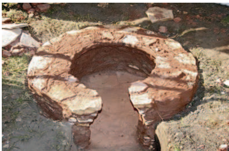
Ryc. 1. Budowa ścian komory ogniowej; fot. M. Krzyżanowska Fig. 1. Construction of the fire chamber walls; photog. M. Krzyżanowska
