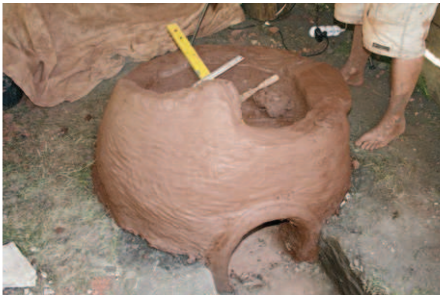
Ryc. 3. Budowa ścian komory ogniowej; fot. M. Krzyżanowska Fig. 3. Construction of the fire chamber walls; photog. M. Krzyżanowska
