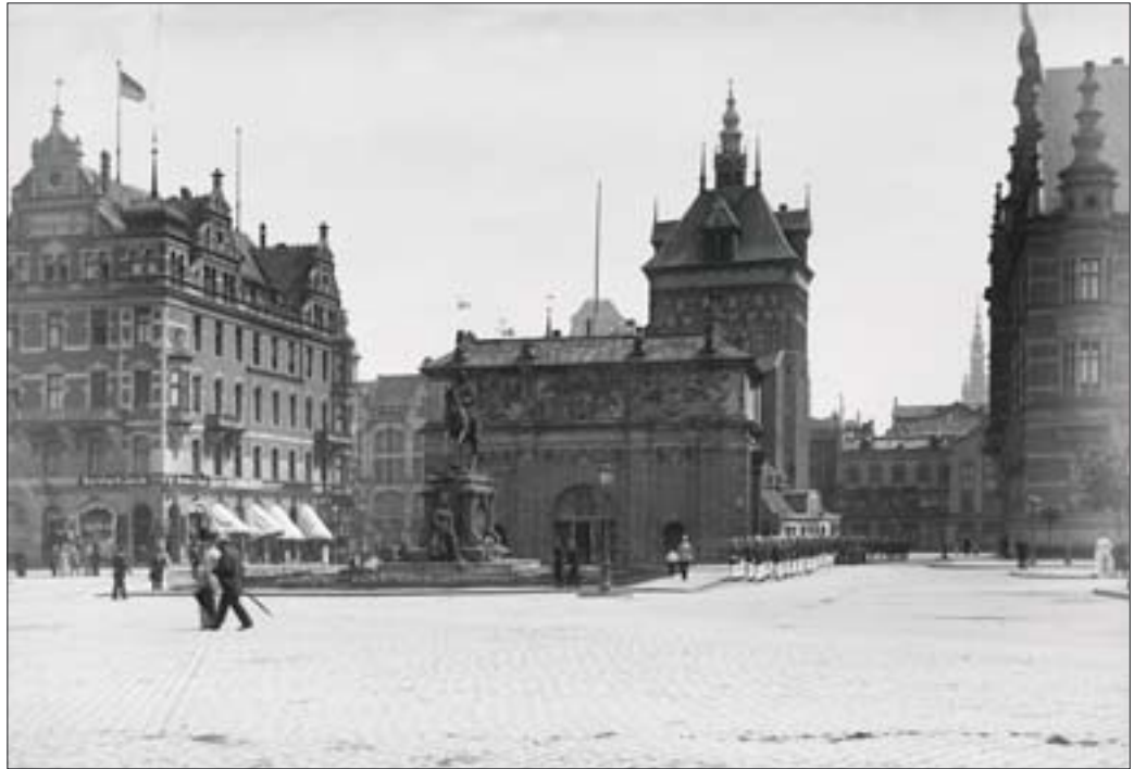
18. Brama Wyżynna, 1914 r. Fot. A. Ziemens. 18. Wyżynna Gate, 1914. Photo: A. Ziemens.
