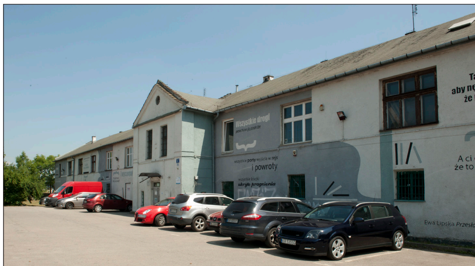
Fot. 19. Budynek dawnego składu solnego w Podgórzu przy ul. Na Zjeździe 8 (Fot. Artur Grzybowski, 2016 r.)
