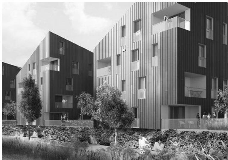
Fotografia 4. Zabudowa nad Kaufhauskanal.
