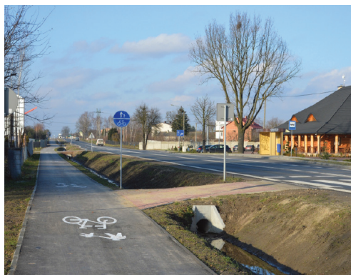
Fot. 3. Ciąg pieszo-rowerowy wzdłuż drogi krajowej nr 9 na odcinku Radom-Skaryszew Fot. S. Pawłowski
