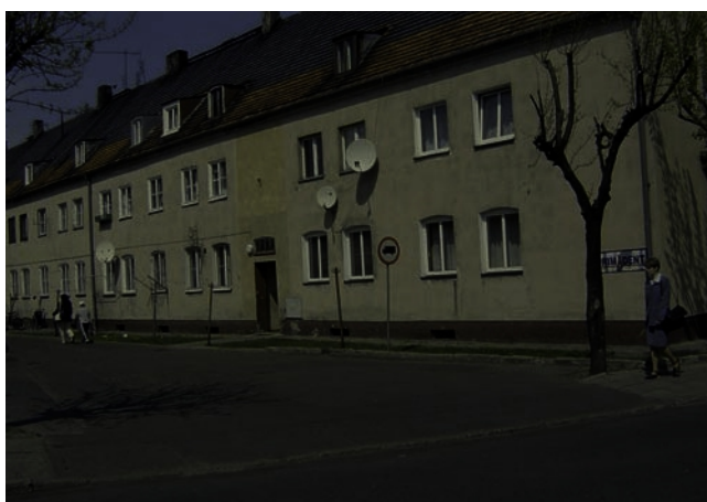
Fot. 4. Budynek z mieszkaniami komunalnymi we Wrześni. Fot. H. Zaniewska
