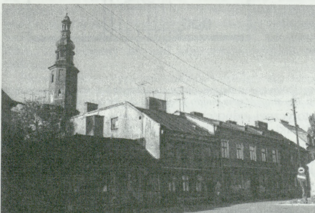
6a. Widok na ul. Szewską z placu przy kościele ewangelickim. Istniejącą zabudowę tworzą domy jednopiętrowe, wpisane do rejestru zabytków
