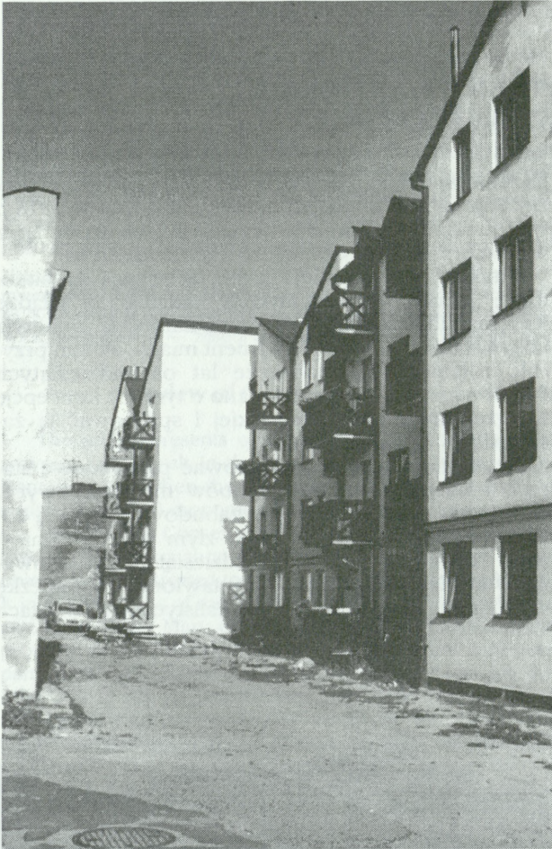
2a. Dom Spółdzielni „Starówka” przy ul. Szwarlikowskiej, 1987-1989 wg projektu dr. arch. T. Kazimierskiego. Z lewej zabudowa gospodarcza ratusza (d. odwach). W parterze zamiast handlu i usług — mieszkanie z balkonami; zupełnie niefunkcjonalne, wbrew przepisom prawa budowlanego. Podniesiona niweleta ulicy pogorszy tę sytuację
