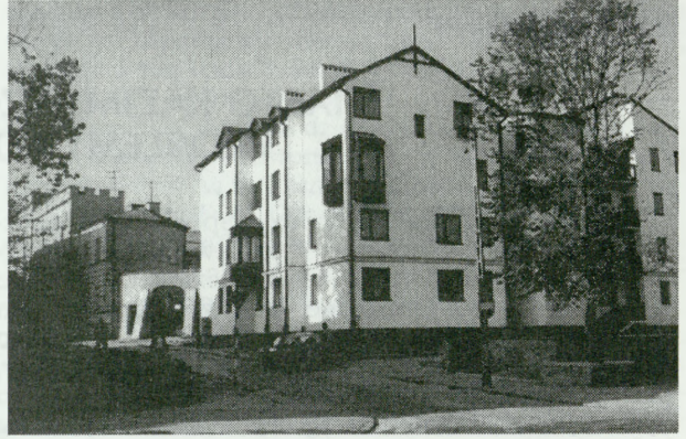
2b. Ten sam dom od ul. Reja. W głębi ul. Wolność tytu ratusza. Układ szczytowy dachów obcy radomskiej tradycji. Domy „upiększono” nowinkami postmodernizmu. Nie wykorzystana szansa umieszczenia usług na parterze, bądź wykorzystania spadku do ul. Reja z poziomu piwnic, które można by zrównać z poziomem chodnika ul. Reja. Na I planie odtworzenie hipotetyczne murów obronnych, wys. 1,2-1,5 m. Czy nie za duża?
