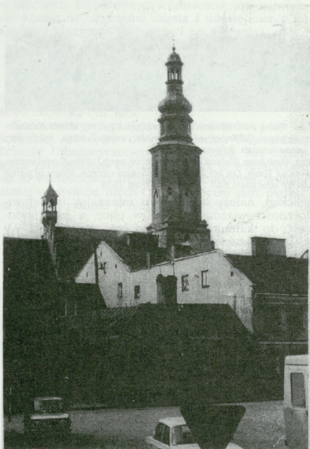
11. Widok z placu przy kościele ewangelickim na wieżę i dach fary. Na I planie zabudowa ul. Szevskiej. Nawarstwianie planów, 6 linii gzymsów i kalenic podkreśla układ horyzontalny. Szczególne miejsce, fascynujące rysowników, malarzy i fotografików m.in. malowane przez Andrzeja Wajdę, ucznia radomskiego liceum. Zdjęcie z 1978 r.
