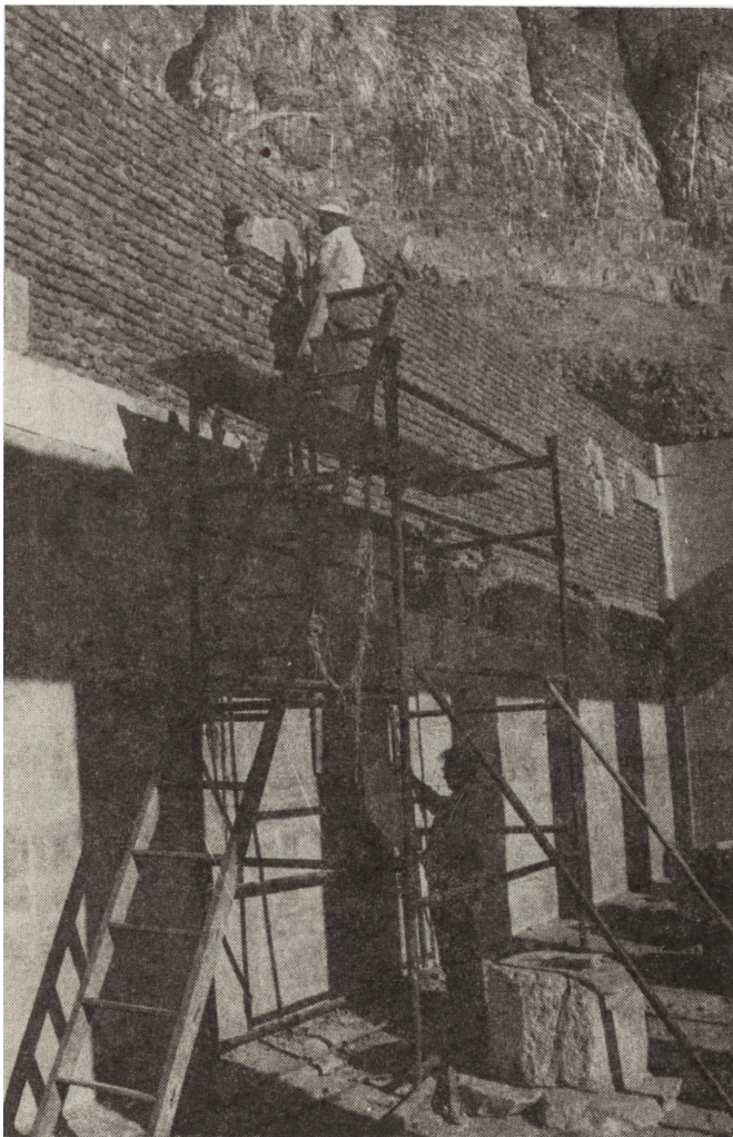
11. Deir-el-Bahari, świątynia królowej Hatszepsut, osadzanie oryginalnych bloków w ceglanej konstrukcji zachodniej ściany górnego portyku (fot. Z. Wysocki)
