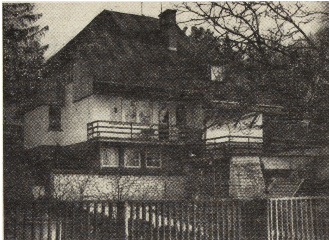
28. Kazimierz Dolny, willa „Jagódka” przy ul. Krakowskiej, projektował arch. B. Kulawczuk, 1976 r. (fot. J. Żurawski)
