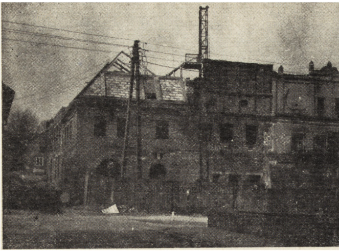
17. Kazimierz Dolny, ulica Senatorska, odbudowa kamienic nr 1–7 według projektu arch. H. Dąbrowskiego, stan z kwietnia 1981 r. (fot. J. Żurawski)
