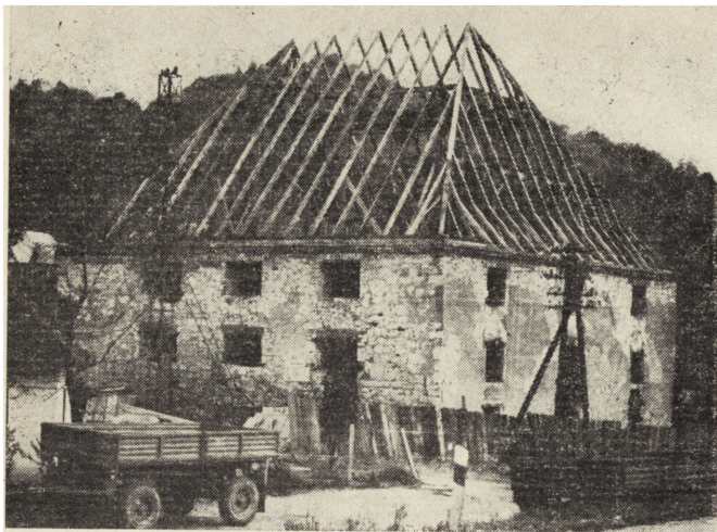
23. Kazimierz Dolny, spichlerz „Pod Wianuszkami” w trakcie odbudowy, stan z maja 1980 r. (fot. J. Zurawski)
