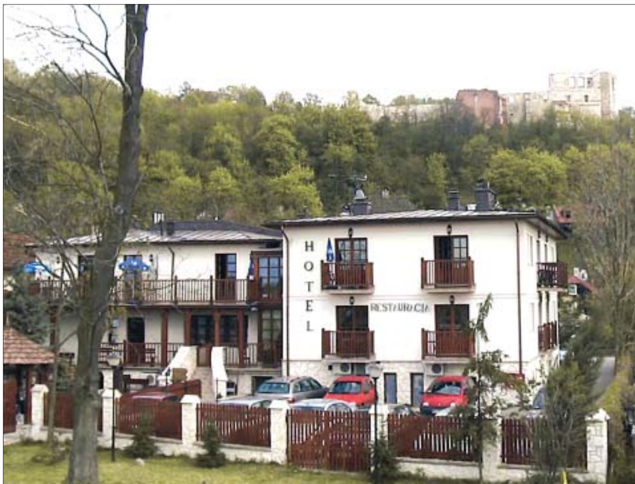
13. Hotel Dwa Księżyce – do takiej postaci można rozbudować niewielki domek. Fot. B. Szmygin.
