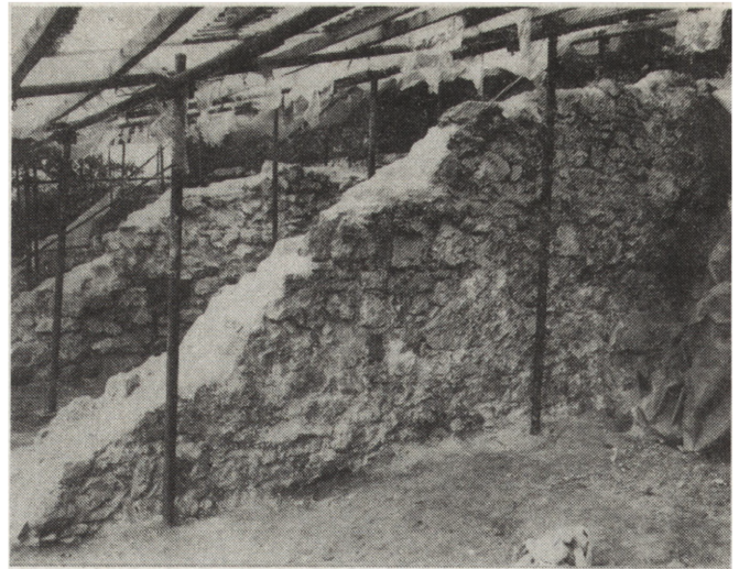
6. Relikty murów przy północnej elewacji pałacu, na pierwszym planie mur renesansowy F2, w tle mur F3 — stan po konserwacji, widoczna warstwa ochronna na koronie muru (fot. K. Jakubek)
