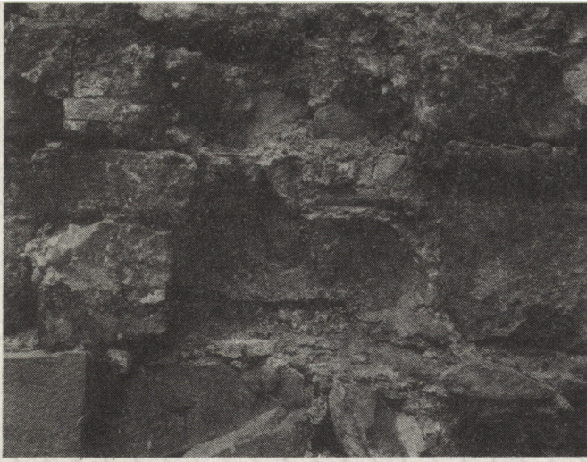
5. Fragment muru północnego nawy kościoła Św. Gereona z odciskiem bazy kolumny — stan po konserwacji (fot. K. Jakubek)
