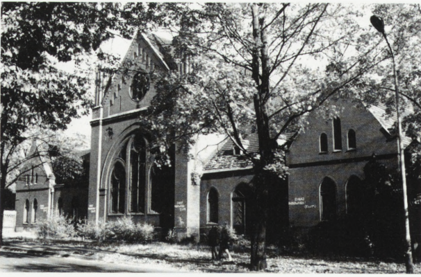
10. Dom przedpogrzebowy przy nowym cmentarzu żydowskim w Gliwicach, zbudowany w 1902 r. w stylu neogotyckim, z halą główną o sklepieniu krzyżowo-żebrowym z malowidłami przedstawiającymi gwiaździste niebo
