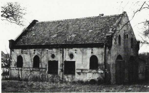
9. Dom przedpogrzebowy przy cmentarzu żydowskim w Pyskowicach, zbudowany w 1860 r.
