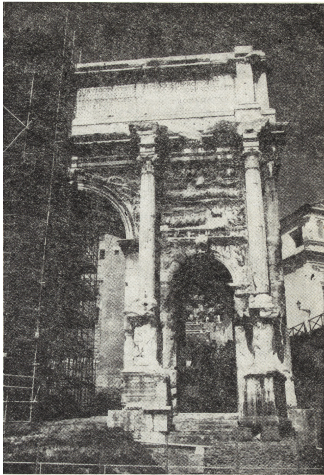
2. Łuk Septymiusza Sewera w Rzymie w trakcie konserwacji (Roberto Nardi z zespołem Centro Conservazione Archeologia; część zasłonięta z charakterystycznymi nawarstwieniami typu „crosta nera”, prace przed oczyszczeniem)
