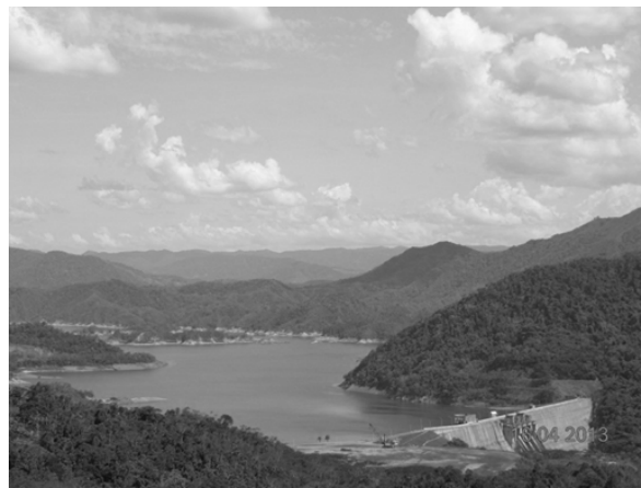
FIGURA 2. EMBALSE- PROYECTO HIDROELÉCTRICO PORCE II- DESDE LA VEREDA EL ENCANTO
