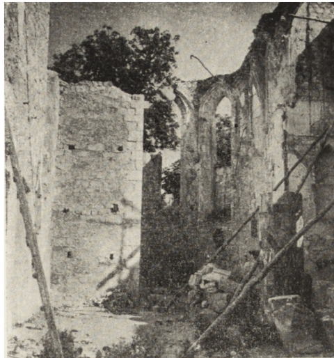
Ryc. 84. — Stopnica — woj. kieleckie. Kościół par. po zniszczeniu. Widok na wnętrze prezbiterium.
