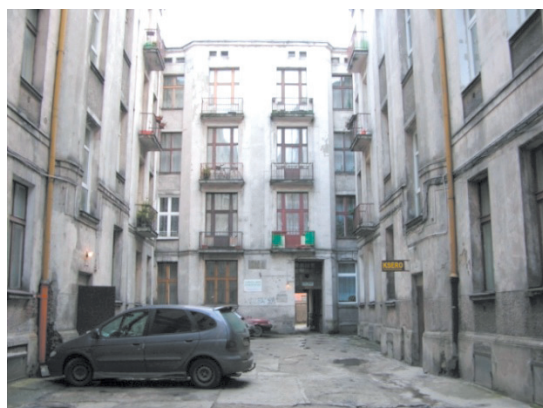
Fot. 2. Nieremontowane podwórko przy ulicy Narutowicza 47
