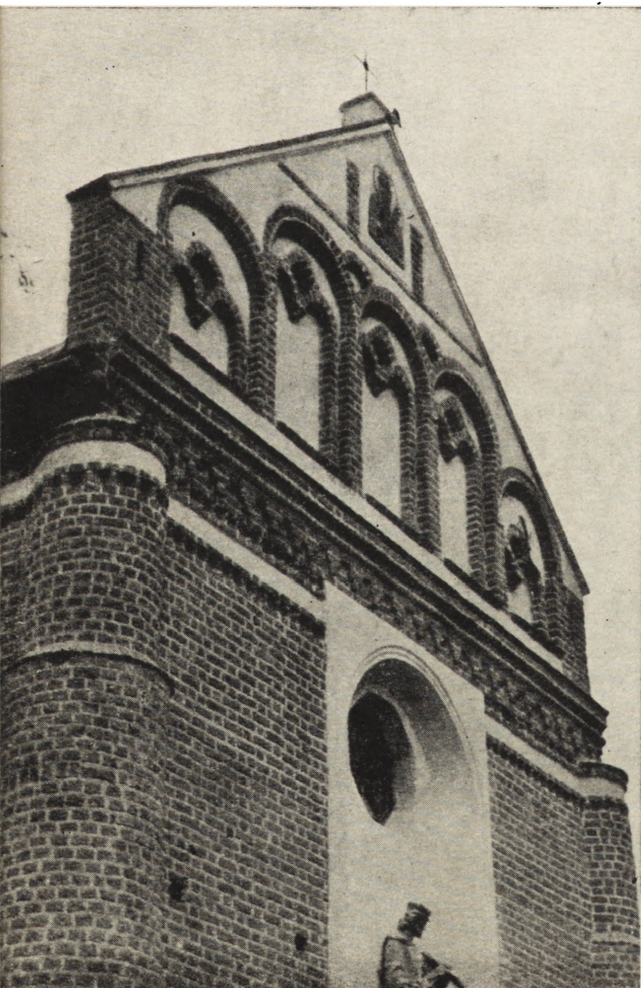
Ryc. 314. Piaseczno — elewacja wschodnia kościoła, po konserwacji.
