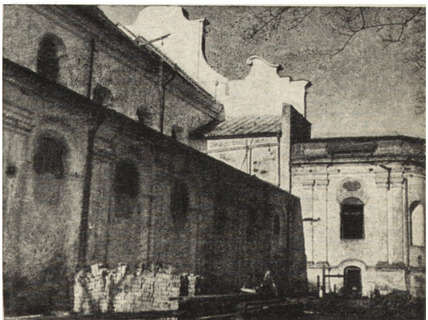
Ryc. 309. Kobyłka, pow. Wołomin — elewacja północna kościoła w czasie prac konserwatorskich.
