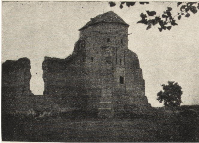
Ryc. 310. Liw, pow. Węgrów — elewacja północna zamku, przed konserwacją.
