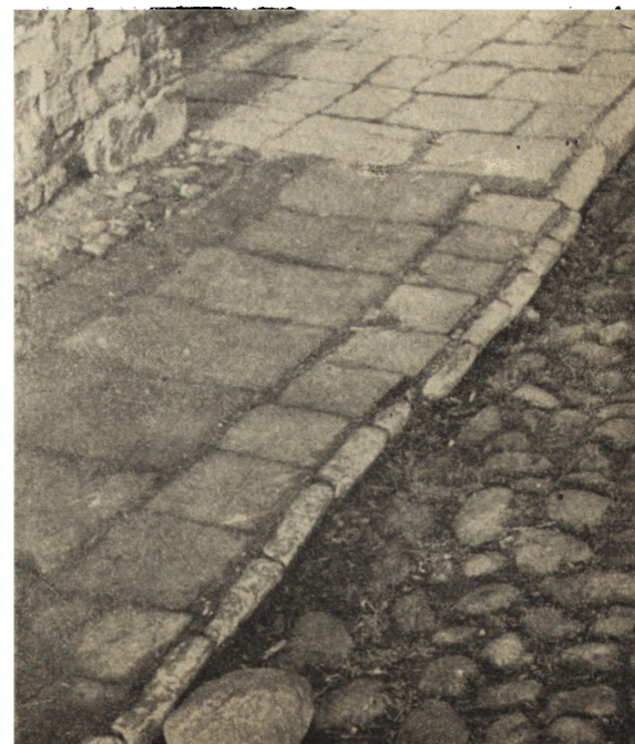
Ryc. 203. Chodnik z płyt kamiennych i jezdni z okrągłaków.
