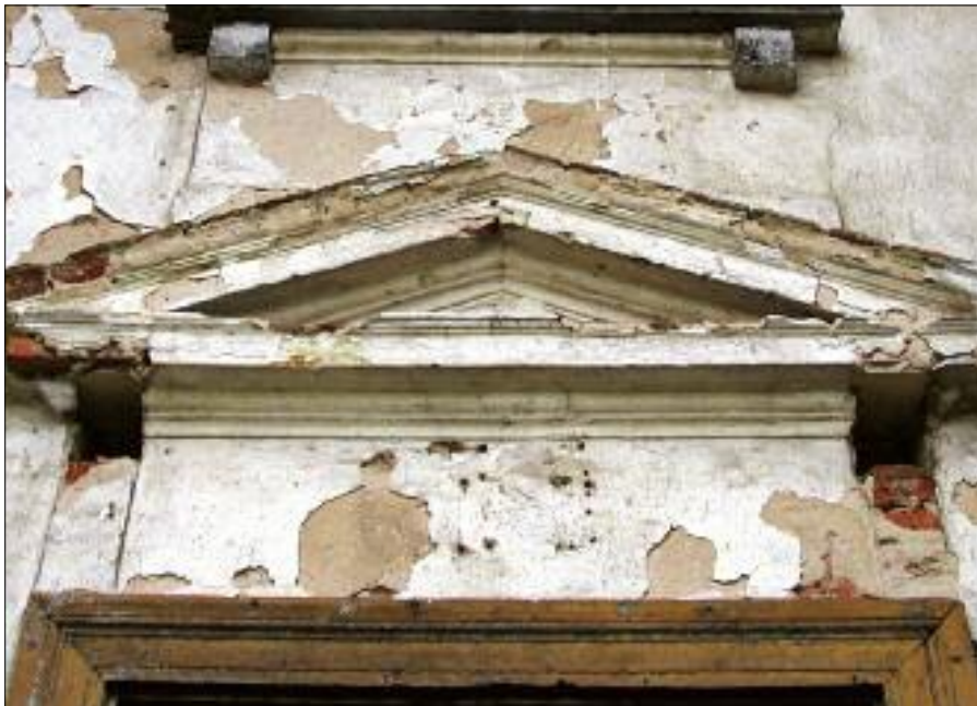
18. Oryginalne tynki z nawarstwieniami kolorystycznymi zachowane na elewacjach pałacu. Fot. M. Skarżyńska-Wawrykiewicz, 2009 r.
