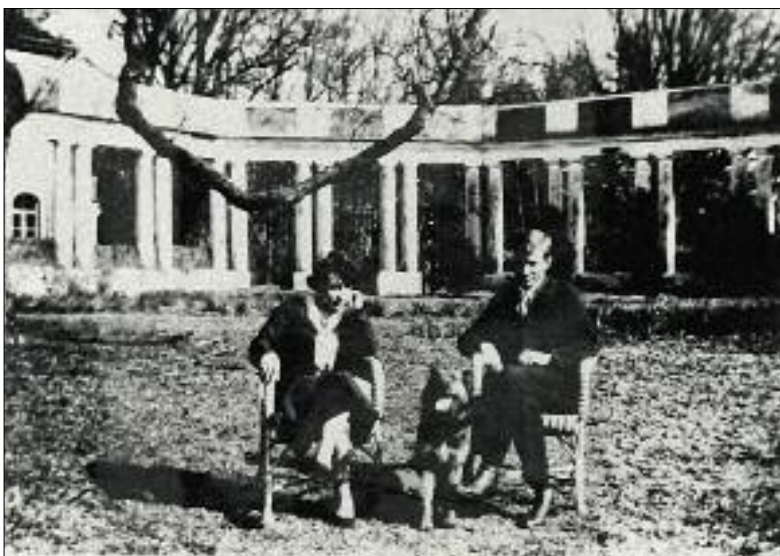
30. Widok na wschodnią galerię z podjazdu. Fot. nn., 1931 r. (Archiwum Delegatury w Płocku WUOZ w Warszawie).
