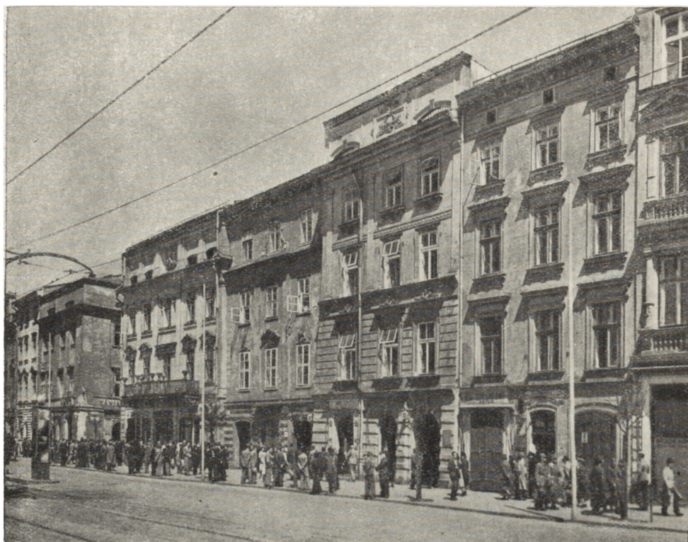
Ryc. 163. Rynek Główny — linia A—B. Kamienice nr 36—40. Zabudowa historyczna zniekształcona. Dawne sienie zamienione przeważnie na sklepy i przedzielone na kilka wewnątrz. Fasady przerobione w 2 poł. XIX w. i nadbudowane. Wysokie, spękane oficyny otaczają ciasne podwórka studnie. Detale zagubione. Nadmierne zagęszczenie biurami i punktami usługowymi.
