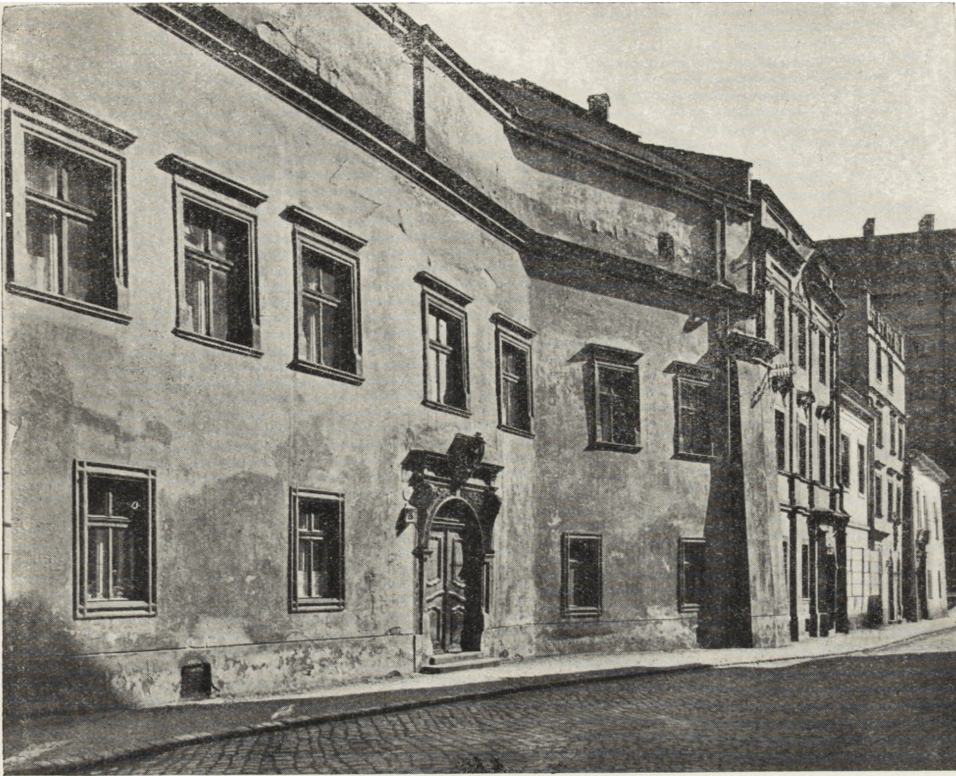
Ryc. 161. Fragment ul. Kanoniczej (dom nr 18). Najbardziej urocza ulica starego Krakowa wykazuje poważne zniekształcenia i oszpecenia. Renesansowe (na gotyckich zrębach) w większości kamienice utraciły attyki i pierwotne dachy, dekorację rzeźbiarską fasad oraz dawną stolarszczyznę okien i częściowo bram. Podworcze zniekształcone zabudową i zaniedbane. We wnętrzach gdzieś polichromie, stropy, portale.
