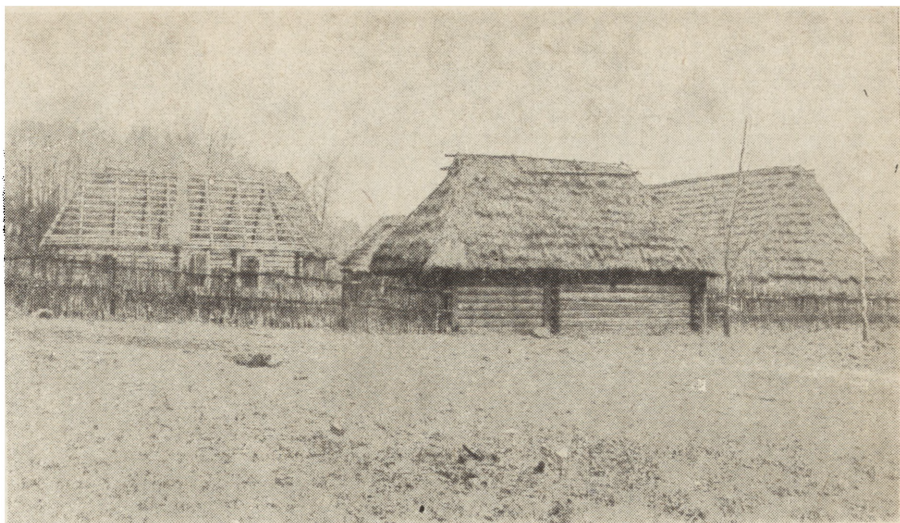
3. Chorzów, skansen, zagroda z subregionu Górzan, chałupa Krasów podczas montażu (fot. W. Cwikliński, 1983)
