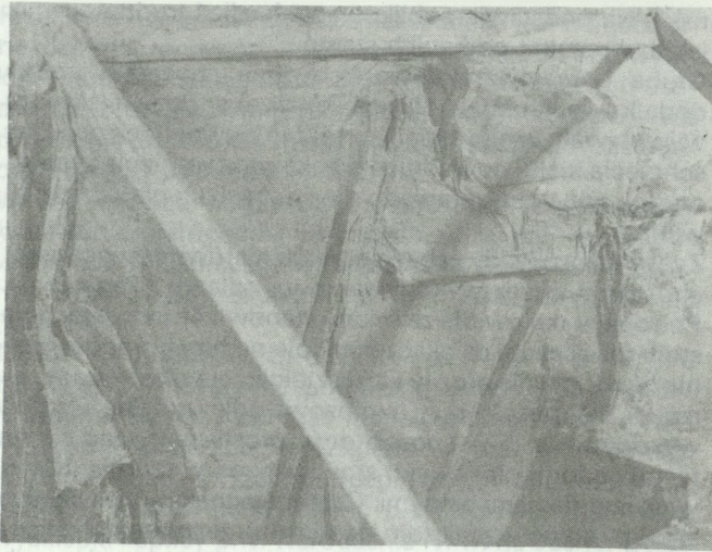
6. Formowanie gipsowego negatywu na gotyckim malowidle z przedstawieniem papieża w absydzie kościoła p.w. św. św. Jana i Katarzyny w Świerzawie. (fot. G. Schulze-Głazik, 1978)
