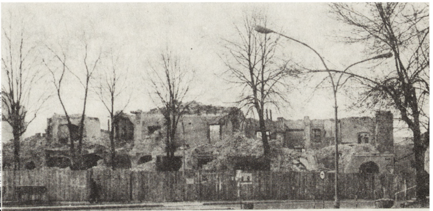
2. 3. Miechów, południowa pierzeja rynku w 1976 r. i w trakcie rozbiórki w 1977 r. (fot. J. Siudowski)
