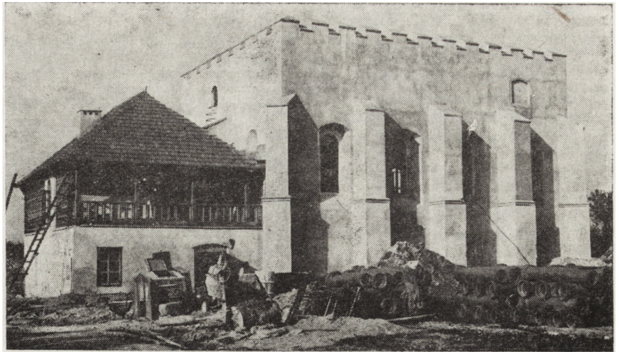
9. Szydłów, synagoga z XVI w. w trakcie restauracji i adaptacji na Gminny Ośrodek Kultury (fot. J. Siudowski, 1981 r.)
