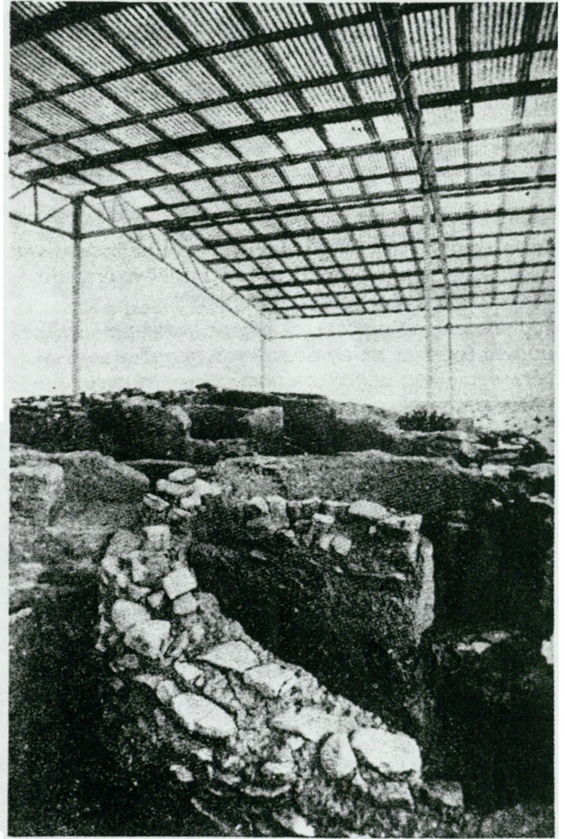
2. Kolavastos Tenta (Cypr), mur z cegły suszonej na słońcu zabezpieczony przed działaniem promieni słonecznych specjalnym dachem oraz powierzchniowo dyspersją wodną żywicy (źródło — jak wyżej, s. 117)
