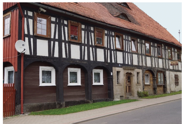
Il. 6. Budynek z konstrukcją przysłupową (z lukowo wyprofilowanymi mieczami i oczepami) oraz ścianką ryglową piętra (charakterystyczny dla Bogatyni) (fot. A. Chądzyński)
