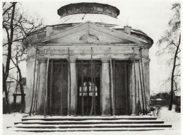
7. Panteon, zabezpieczenie portyku w grudniu 1995 r.
