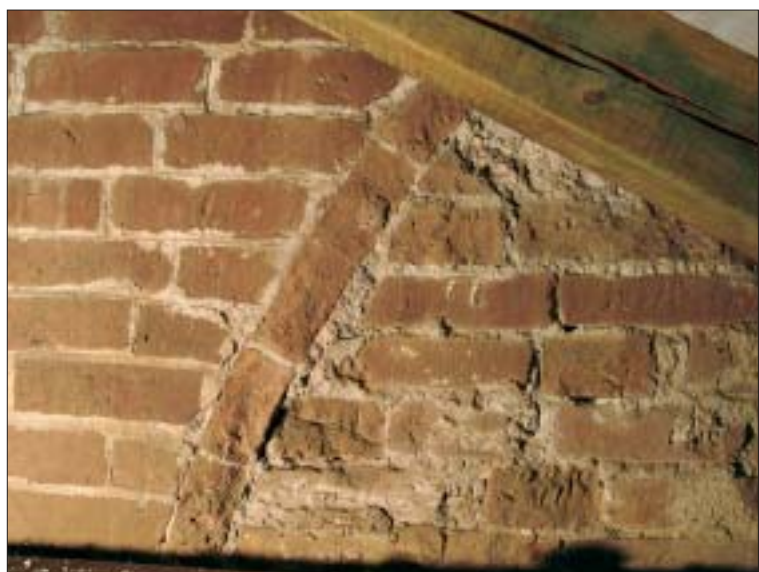
7. Łuk nadportalny widoczny w przestrzeni poddasza kruchty. 7. Arch over a portal seen in the space of the porch attic.
