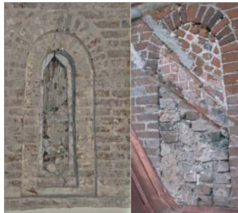
12. Okno zachodnie ściany północnej nawy widoczne od wnętrza kościoła i w elewacji północnej kościoła. 12. Western window in the northern nave wall seen from the church interior and the northern elevation of the church.
