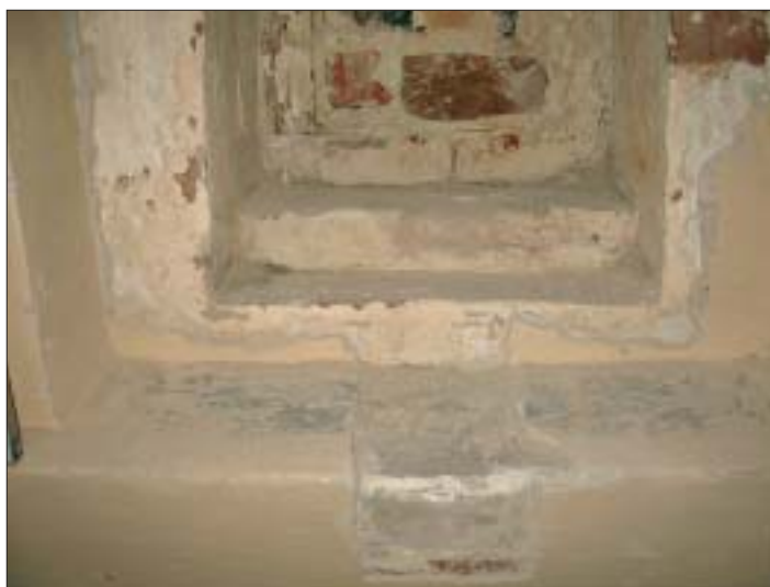
14. Fragment okna środkowego ściany północnej nawy nad poziomem odsadzki muru. 14. Fragment of the central window in the northern nave wall above the level of the wall offset.
