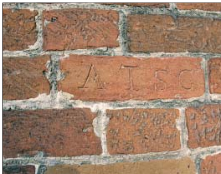
16. Fragment lica ściany południowej nawy z widocznymi śladami obróbki kamieniarskiej cegieł.
