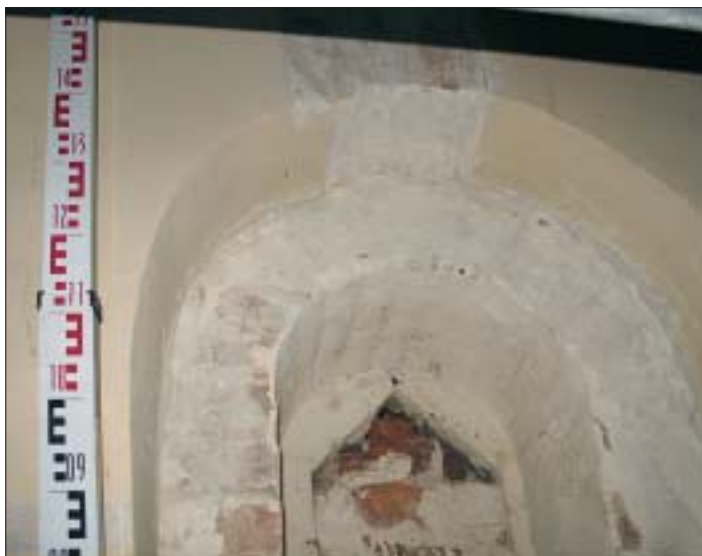
13. Nadproże okna środkowego w ścianie północnej nawy. 13. Window head of the central window in the northern nave wall.
