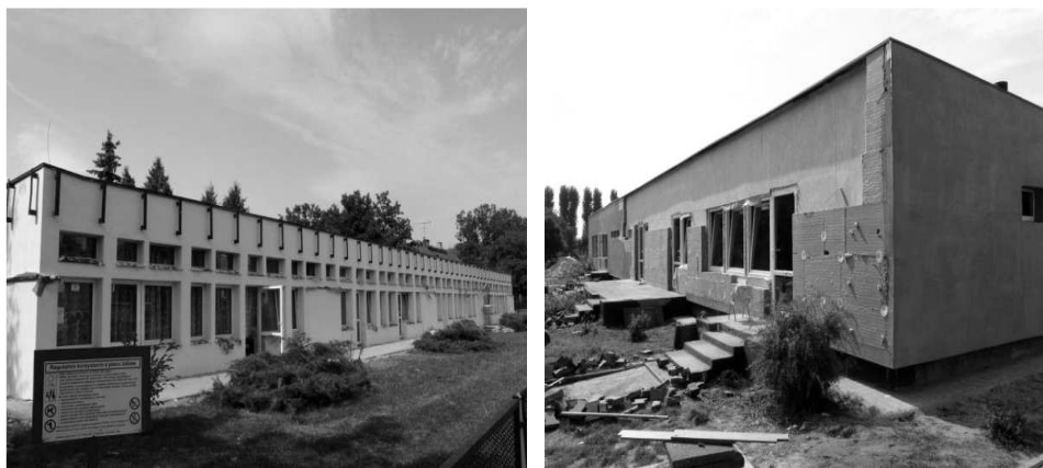
Fot. 7–8. Termomodernizacja przedszkoli – zdjęcia w trakcie wykonywania dociepień Źródło: Studium Wykonalności... (2009)
