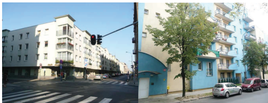
Fot. 3. Budynek przy ul. Nawrot 18/20 Fot. 4. Budynek przy ul. Nowej 40/44
