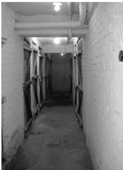
Rys. 18. Piwnica w wieżowcu
