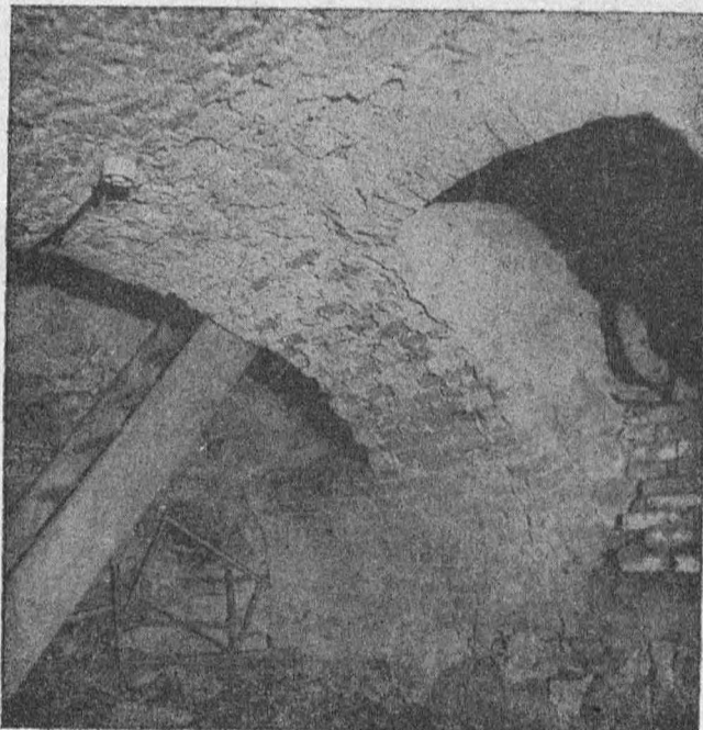
Fot. 3. Ostromecko, „pałac stary”, relikw muru starszego dworu w dolnej partii ściany pomieszczenia piwnicznego nr IV. Sklepienie kolebkowe z XVIII w. Fot. M. Sowińska, 6488/31/1976
