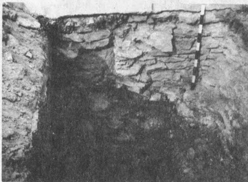
Fot. 5. Lamus-skarbiec, fundament budynku w wykopie IV
