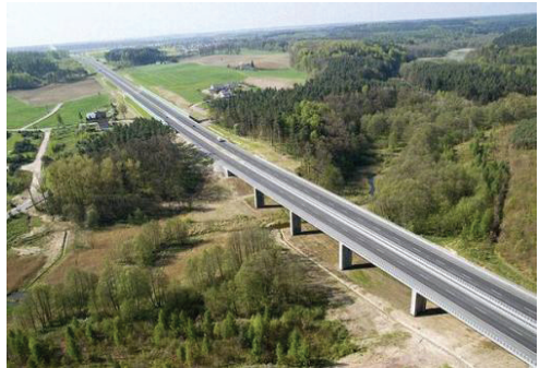
Fot. 4. Przejście dolne dla dużych zwierząt na autostradzie A-1 w Koziarach koło Tczewa
