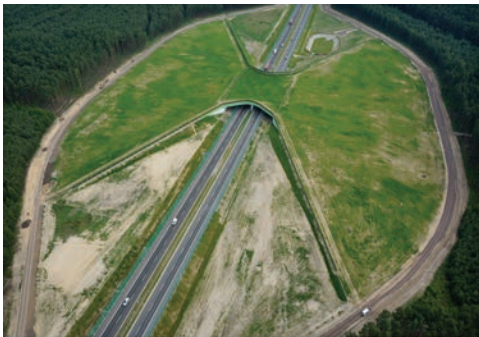
Fot. 3. Przejście górne dla dużych zwierząt na drodze S-3 w Popowie koło Skwierzyny
