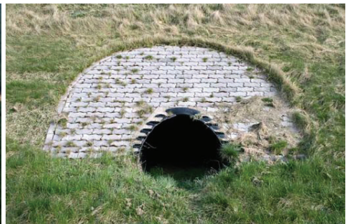
Fot. 6. Przykład przepustu dla małych zwierząt i płazów
