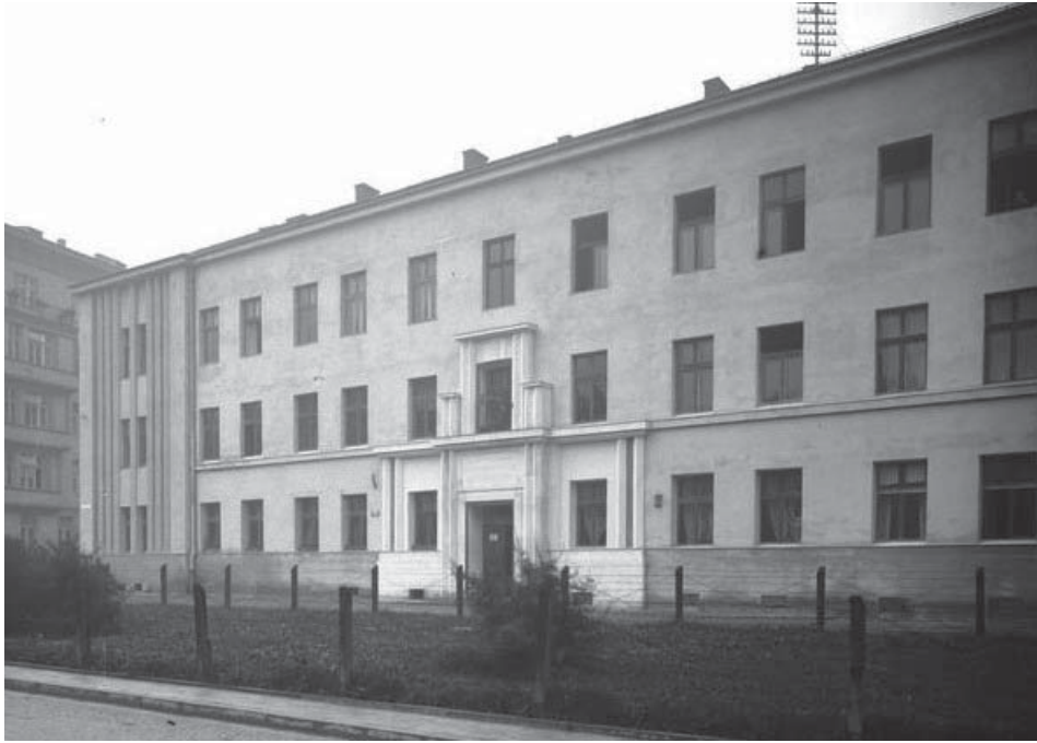
Il. 11. Ul. Retoryka 10–12, Dom Egipski po zmianie elewacji, widok od strony ul. Wygoda (Narodowe Archiwum Cyfrowe, sygn. 1-U-2567-2).
