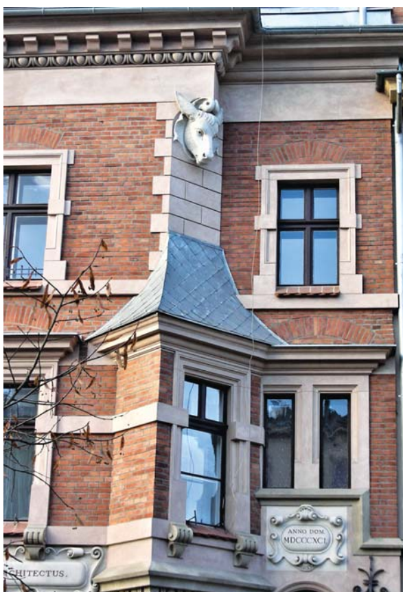
Il. 6. Ul. Retoryka 7, fragment elewacji domu Pod Oślą Głową (fot. T. Węclawowicz).
