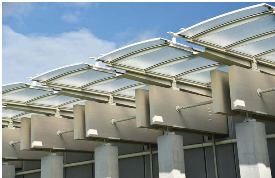
Il. 16. Pawilon Piano – detal dachu. Fot. A. Jasiński.
