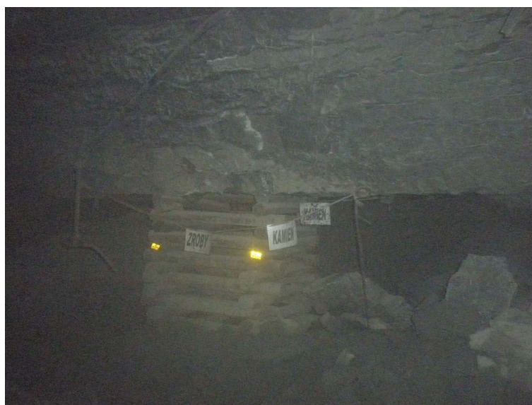
Rys. 4. Kaszt górniczy zabudowany w przestrzeni poeksploatacyjnej (fot.: K. Skrzypkowski)
