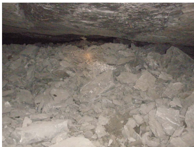
Rys. 3. Przestrzeń poeksploatacyjną wypełnioną podsadzką suchą (skała płonna) w systemie komorowo-filarowym w ZG Polkowice–Sierszowice (fot.: K. Skrzypkowski)
