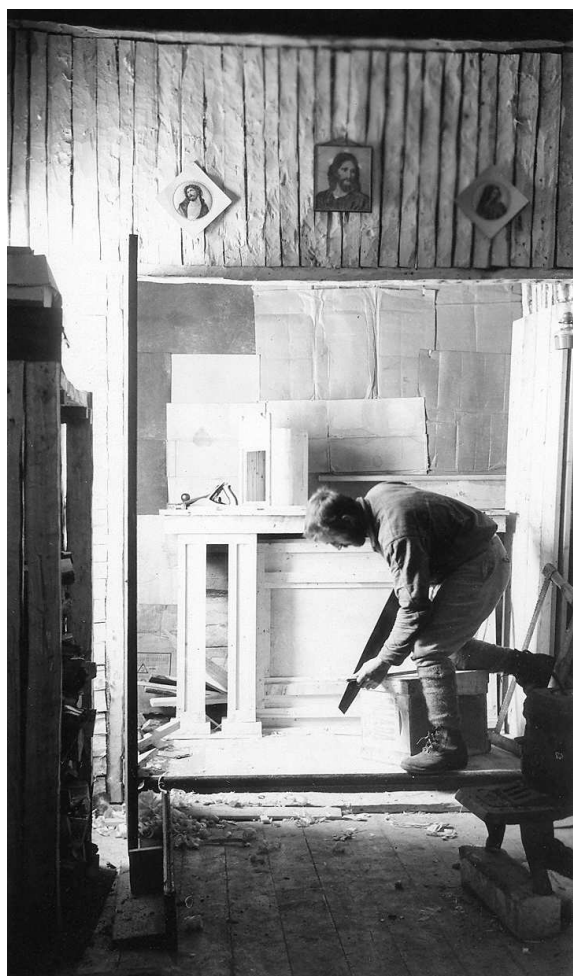
Vieux Comptoir – budowa misji, listopad 1937
