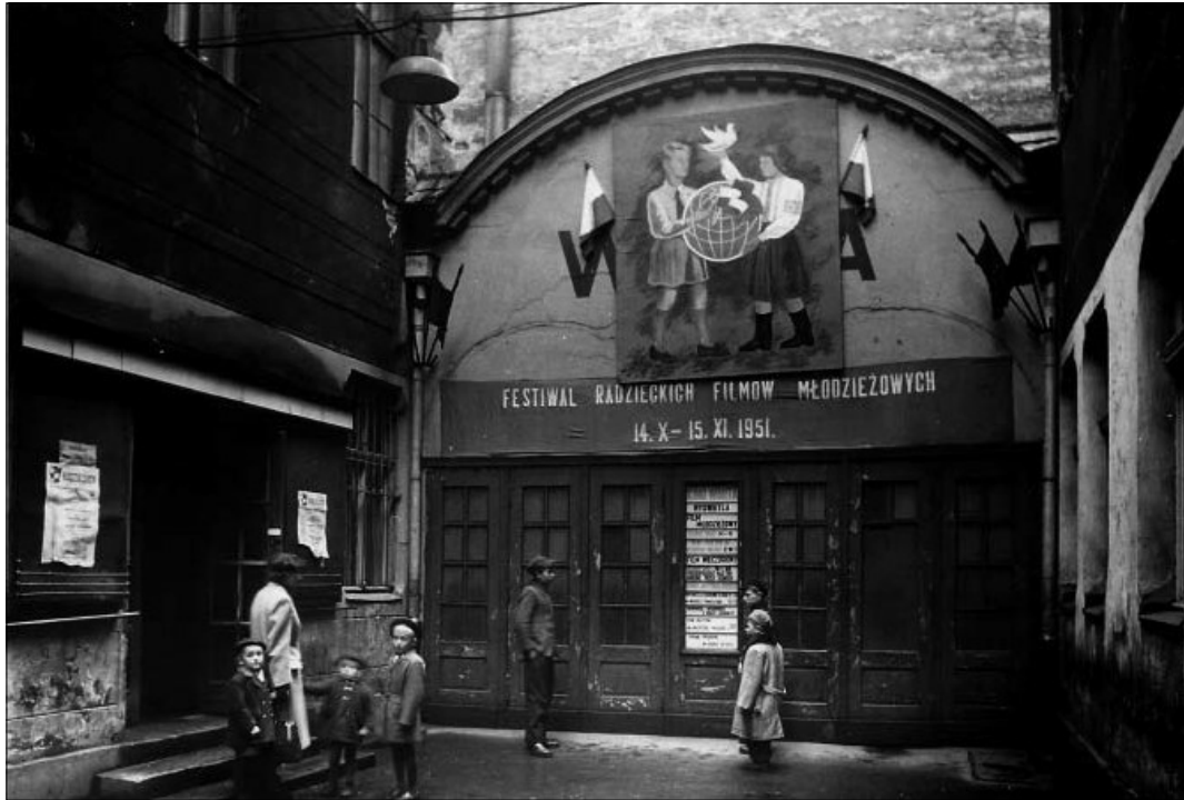
Wejście do nieistniejącego dziś kina Warta w Poznaniu (1951). Jedno z najstarszych kin w Poznaniu (od 1907) wyburzono przy przebudowie ulicy 27 Grudnia w latach 70.
