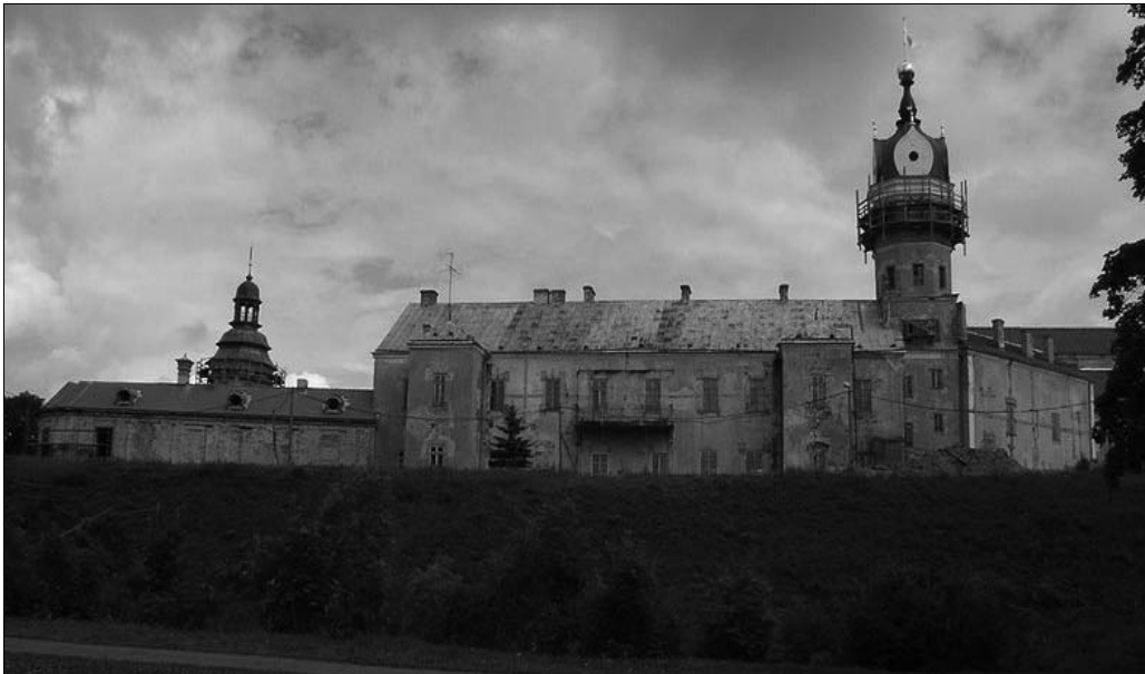
B. Stan obecny po przebudowie wież zamkowych i nakryciu ich hełmami wzorowanymi na rosyjskiej architekturze, co nie ma żadnego uzasadnienia historycznego. Przykład współczesnej przebudowy zabytku, która dzieli i ekspertów i narody
