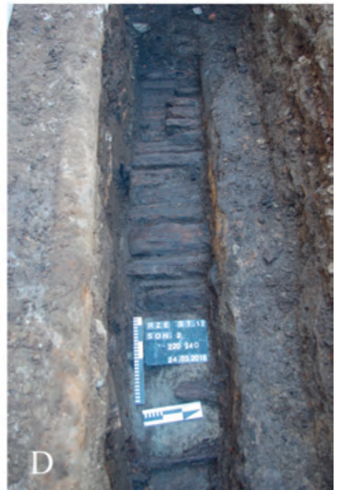
Ryc. 6. Sondaż nr S2 na ulicy Kościuszki w Rzeszowie. A – pozostałości drewnianego moszczenia odkrytego na głębokości 120–140 cm; B – drewniane belki ułożone równoległe do ulicy, odsłonięte na głębokości 140–160 cm; C – fragment drewnianego rynsztoku odprowadzającego wodę; D – fragment drewnianej nawierzchni odkrytej na głębokości 220–240 cm w zachodniej części sondażu. Fot. P. Kocańda
