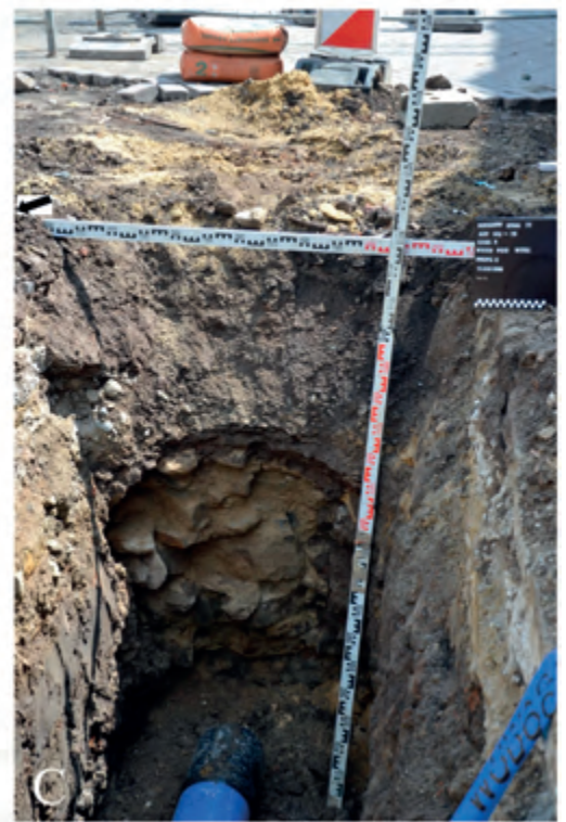
Ryc. 7. Odkrycia poczynione w trakcie nadzoru archeologicznego. A – rozmieszczenie wykopów pod instalacje miejskie oraz odkryte elementy zabytkowe; B – widoczny w profilu wykopu fragment drewnianego moszczenia dawnej drogi; C – gruzowisko kamienne po rozebrzanym murze. Fot. P. Gorazd-Dziuban (2018) Fig. 7. Discoveries made during an archaeological watching brief. A – arrangement of trenches for municipal installations and uncovered historic elements; B – a fragment of the wooden lining of the old street visible in the profile of the trench; C – stone rubble from the demolished wall. Photo P. Gorazd-Dziuban (2018)
